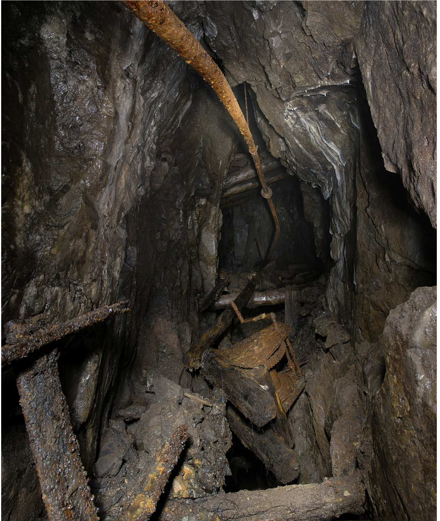
Abb. 4: Blick auf das Absinken 5. Die Versatzmassen unterhalb der Kopfbühne sind großflächig in den Schacht eingebrochen
