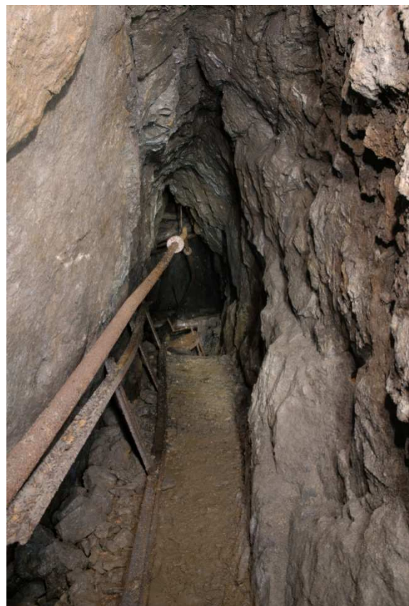
Abb. 7 (links): In der Strecke zwischen den Absinken 4 und 5. Die Sohle in diesem Bereich ist stark zugeschlammmt
