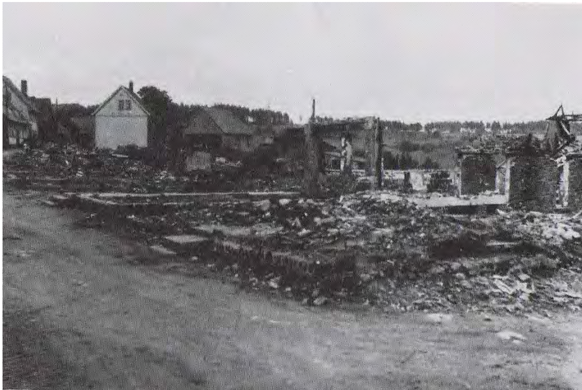
Schulstraße nach der Zerstörung
