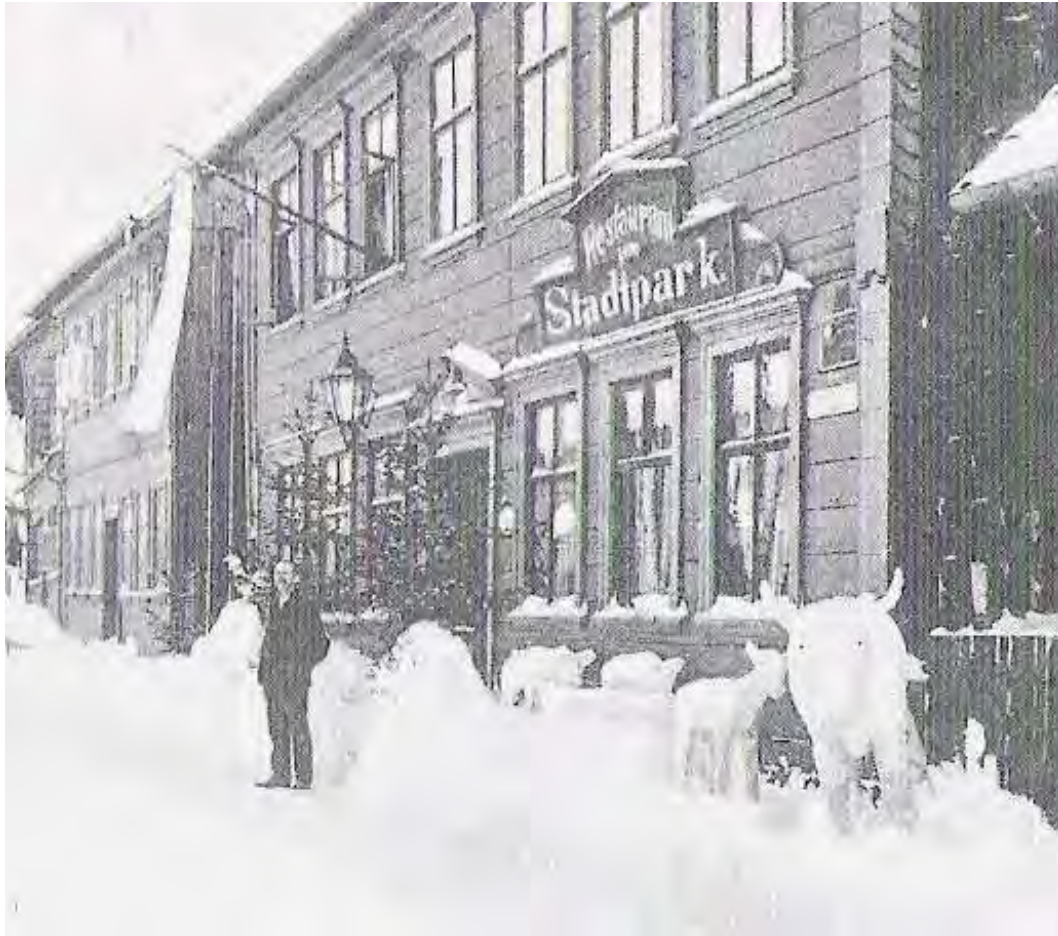
Schulstraße vor der Zerstörung
