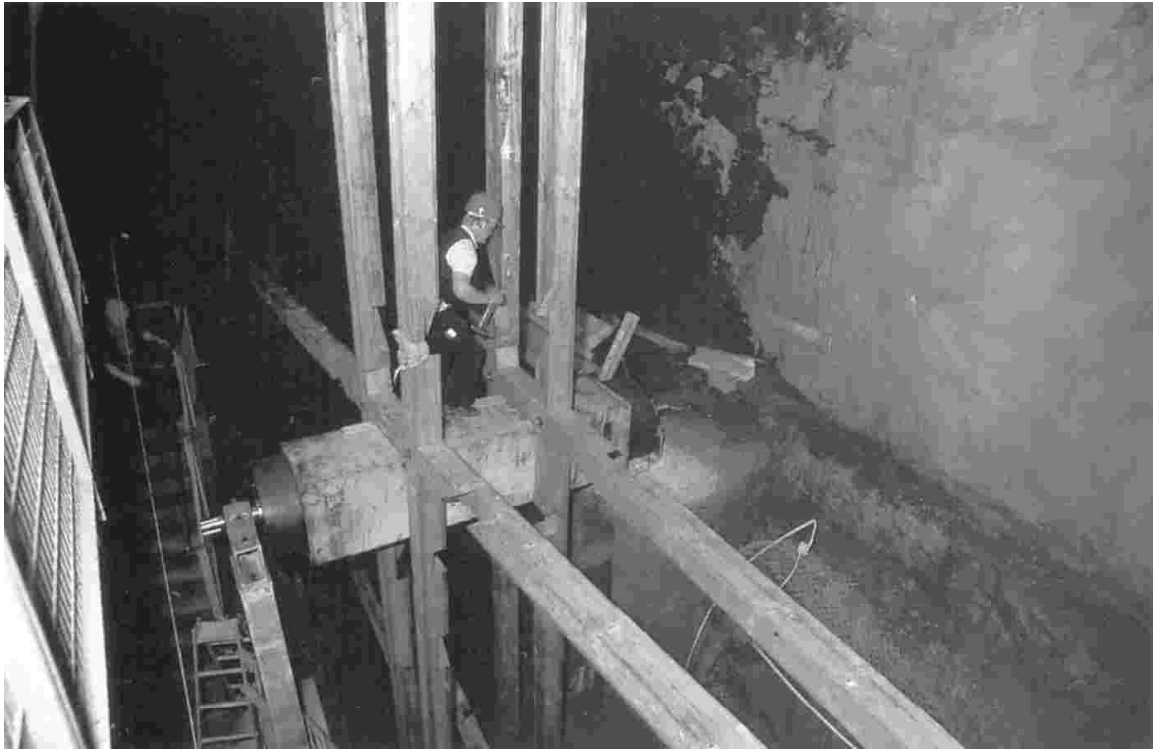
Abb. 13: Die Hauptarme werden eingesetzt
