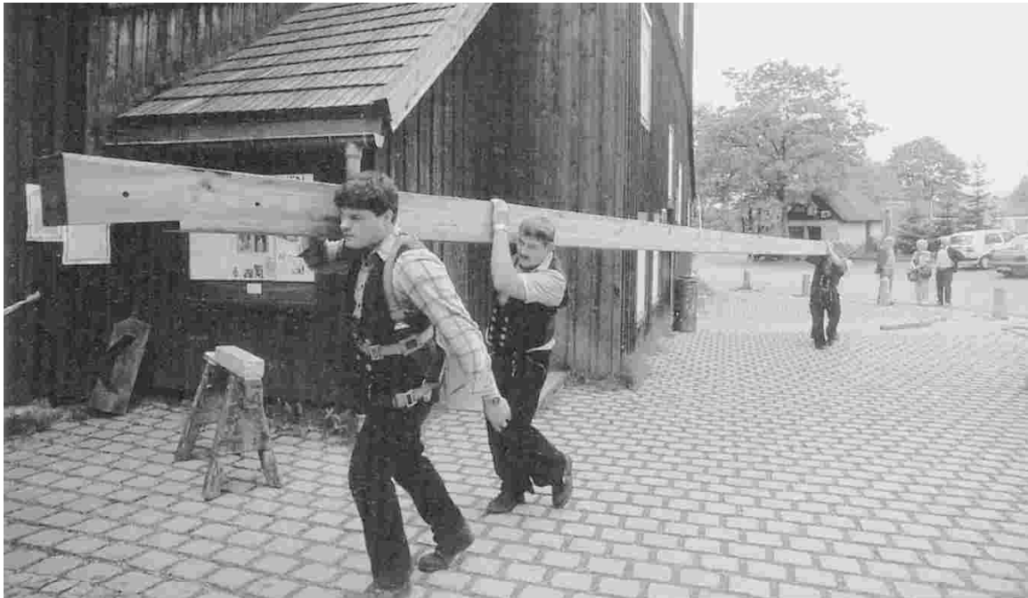
Abb. 12: Zimmerleute tragen einen Hauptarm in die Radstube
