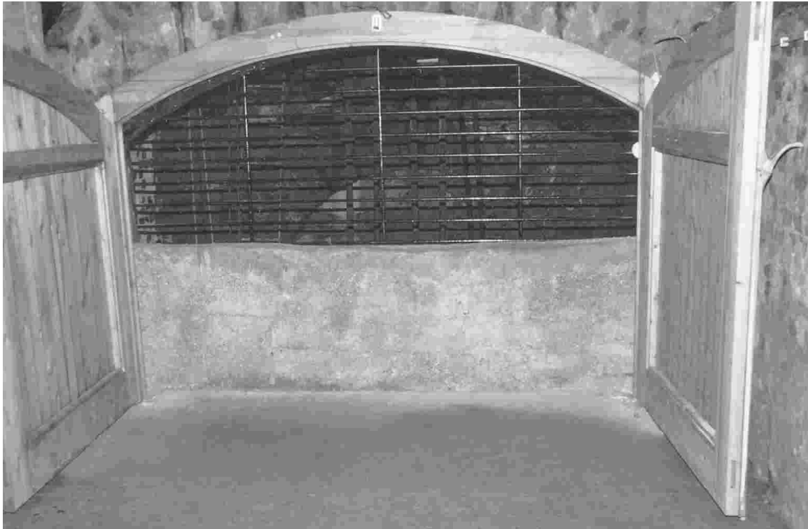
Abb. 14: Blick zur Fahrkunst vor der Sanierung
