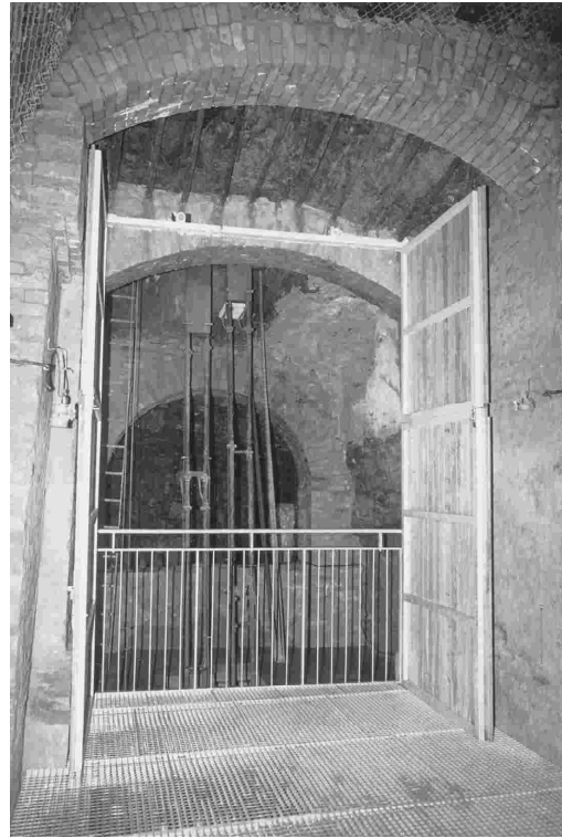
Abb. 15: Blick zur Fahrkunst nach der Sanierung
