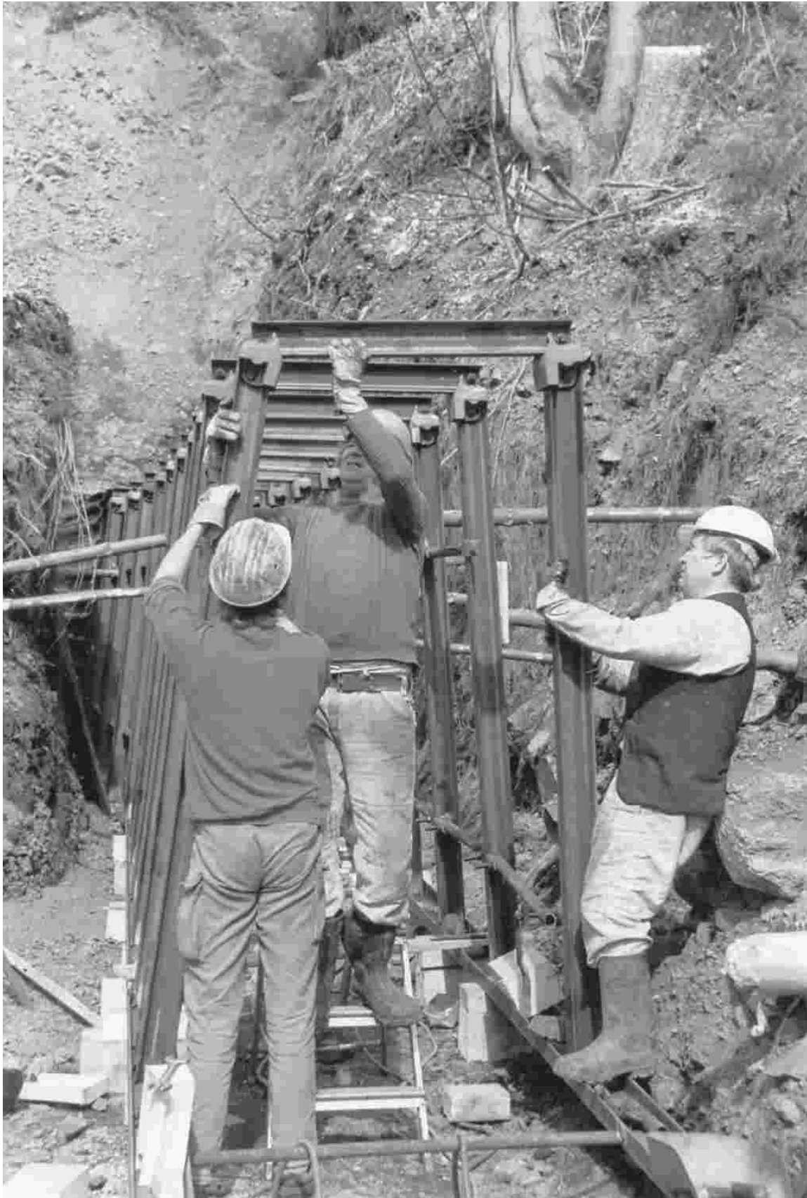
Abb. 11: Der neue Stablausbau im Wasserlösungsstollen
