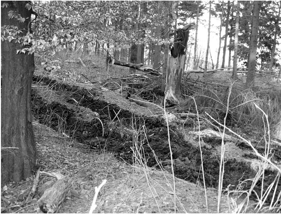
Abbildung 3: Beschädigungen der Claus Friedricher Grabentour am Beerberg durch maschinellen Holzeinschlag Foto: W. Ließmann
