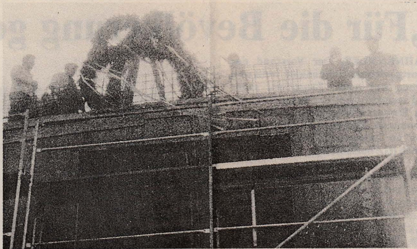
Richtfest im Nebel: Vom Boden aus waren die Handwerker, die die Richtkrone aufzogen, nur als schemenhafte Gestalten zu erkennen.
