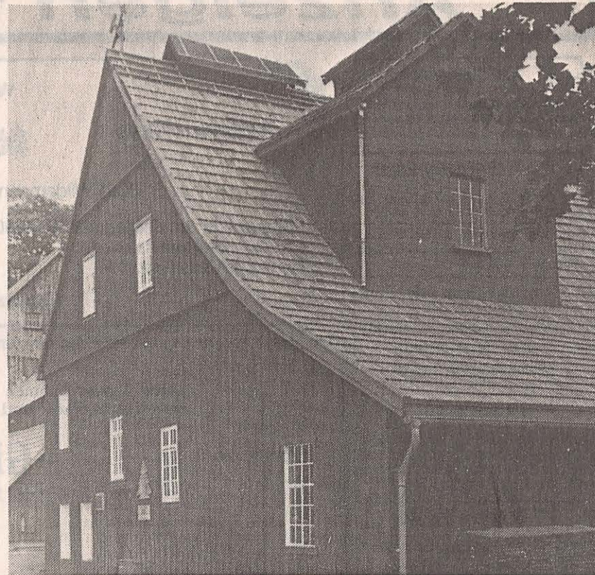
Ein Holzschindeldach erhält der Gaipel des Bergwerksmuseums. Aber die Arbeiten sind von Reklamationen begleitet. Foto: Tempes
