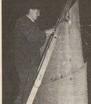
Ein Bauarbeiter durchtrennt mit einem Schweißbrenner die Metallmatten und vergrößert das Loch im Grenzzaun.
