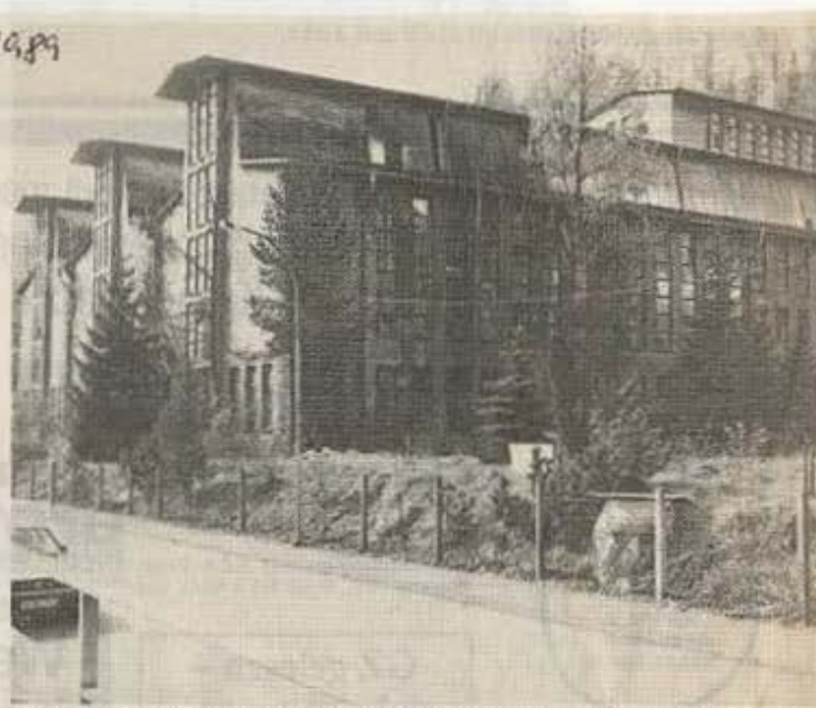
Abbruch in diesem Jahr: Auf dem Gelände der ehemaligen „Schickert-Werke“ soll ein Kurpark entstehen. Foto: Tempes
