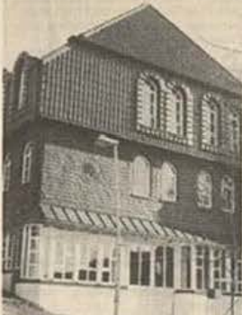
Ein besonders schönes Haus haben die Dachdecker in der Andreasberger Herrenstraße errichtet. Es paßt sich ausgezeichnet der Umgebung an.
