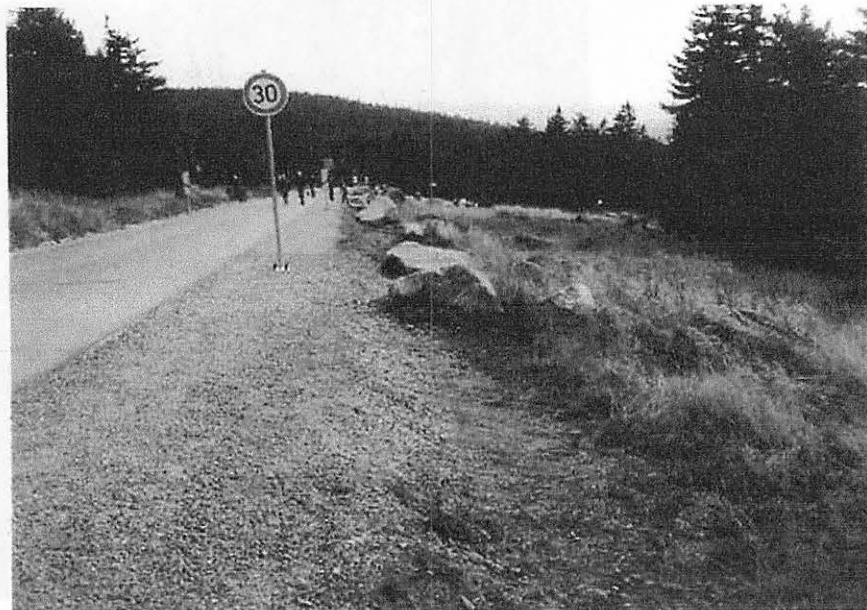
Bild 5: Ansicht der Brockenstraße vor dem Wegausbau – Bereich vor der Knochenbrecherkurve
