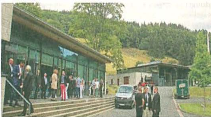
Vor wenigen Jahren ist im Sperrluttal ein Gebäude-Ensemble entstanden, in dem Auszubildende und Meisterschüler des Dachdeckerhandwerks unterrichtet werden.
