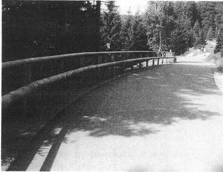
Bild 2: Schutzplanke mit Geländer
