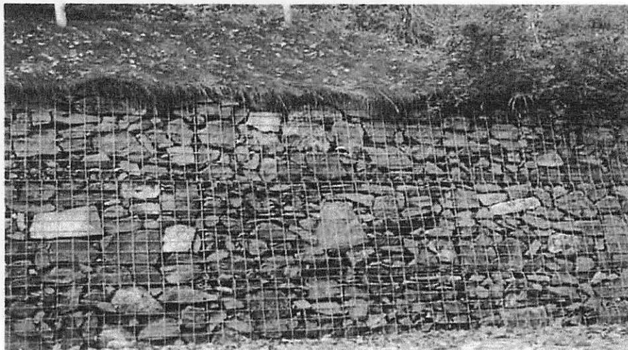
Bild 9: Beispiel mit Ansicht einer Gabione
